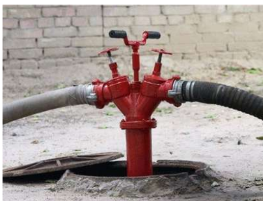
Рисунок 79. Пожарный гидрант.
