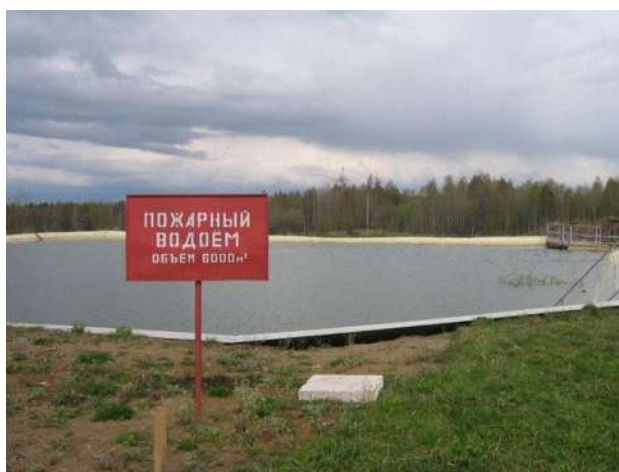
Рисунок 77. Источник (хранилище) воды, используемой при тушении пожаров.
