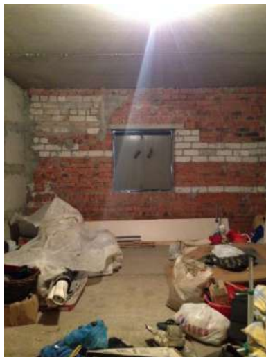
Рисунок 36. Опасное хранение стройматериалов и старых вещей.
